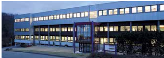
Administration et production
