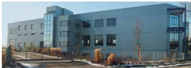
Neubau mit Kunststofftechnik und Motorenmontage
