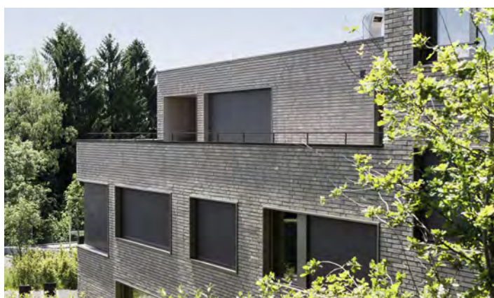
La protection solaire textile avec screens est de plus en plus appréciée.
