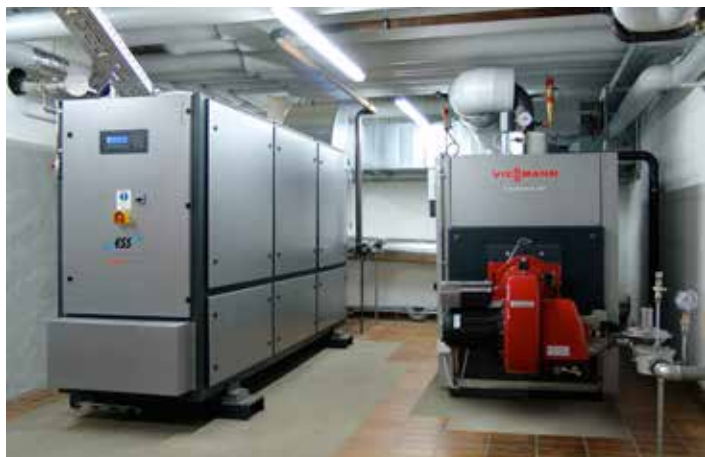
GEIGER-Blockheizkraftwerk und Spitzenlastkessel
