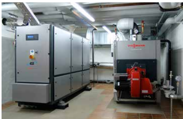
Equipos de cogeneración en la empresa GEIGER
